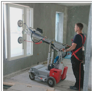
Smartlift SL208 bei der Fenstermontage
