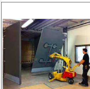
Transport und Einbauhilfe von Toren / Türen
